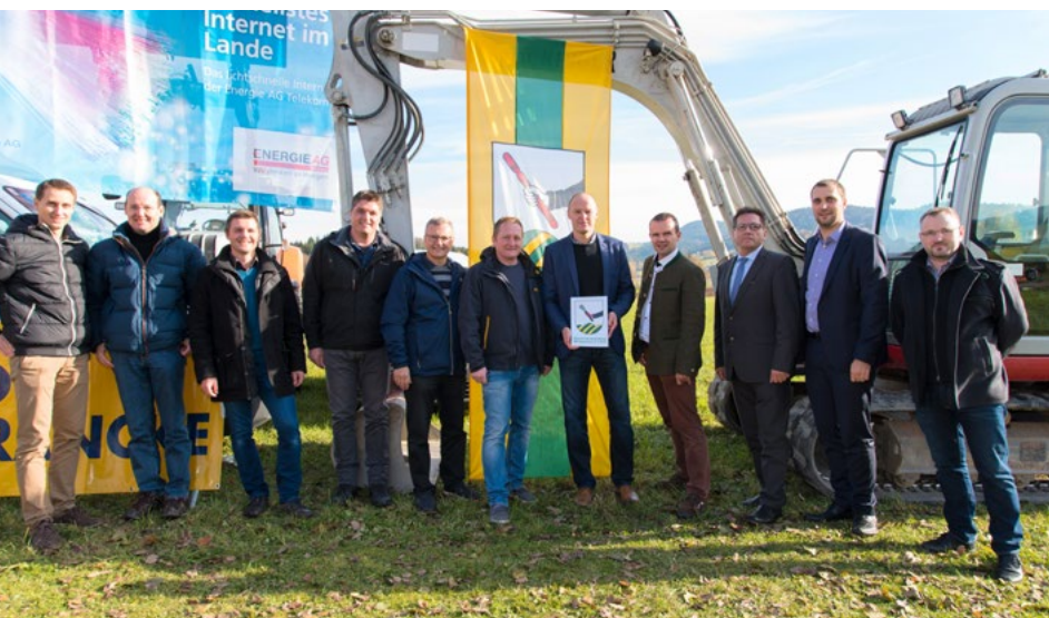
Abbildung 2: Im Anschluss an den Spatenstich gratulierte Volker Dobringer vom Breitbandbüro OÖ Projektleiter Thomas Riemer und übergab ein „neues“ Gemeindewappen, in dem ein Glasfaserbündel den traditionellen Haptsteckn (ein aus Holz gedrechselter Stab, an welchem Informationen angebracht werden und von Haus zu Haus weitergegeben wird – war früher das wichtigste Kommunikationsmittel) ersetzt und uns als Glasfaser-Gemeinde darstellt.
